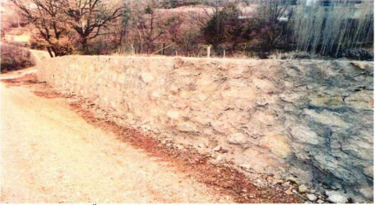
2- Taşyaka mahallesi Üçmeşe Sokakta yol genişletmesi kapsamında 200 m2 betonlu taş duvar yapılmıştır.
